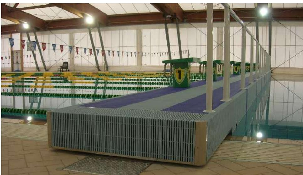
L'alimentazione avviene mediante speciali batterie a 24V riposte in appositi scompartimenti a tenuta stagna in acciaio inox. Per la movimentazione viene utilizzato un apposito radiocomando, semplice e intuitivo, per rendere la movimentazione del pontile semplice ed affidabile.
