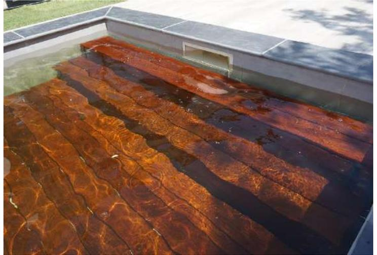
Sfruttando il principio di Archimede, mediante un sistema di galleggiamento completamente nascosto nella struttura, si riesce ad avere una superficie piana e completamente emersa.
